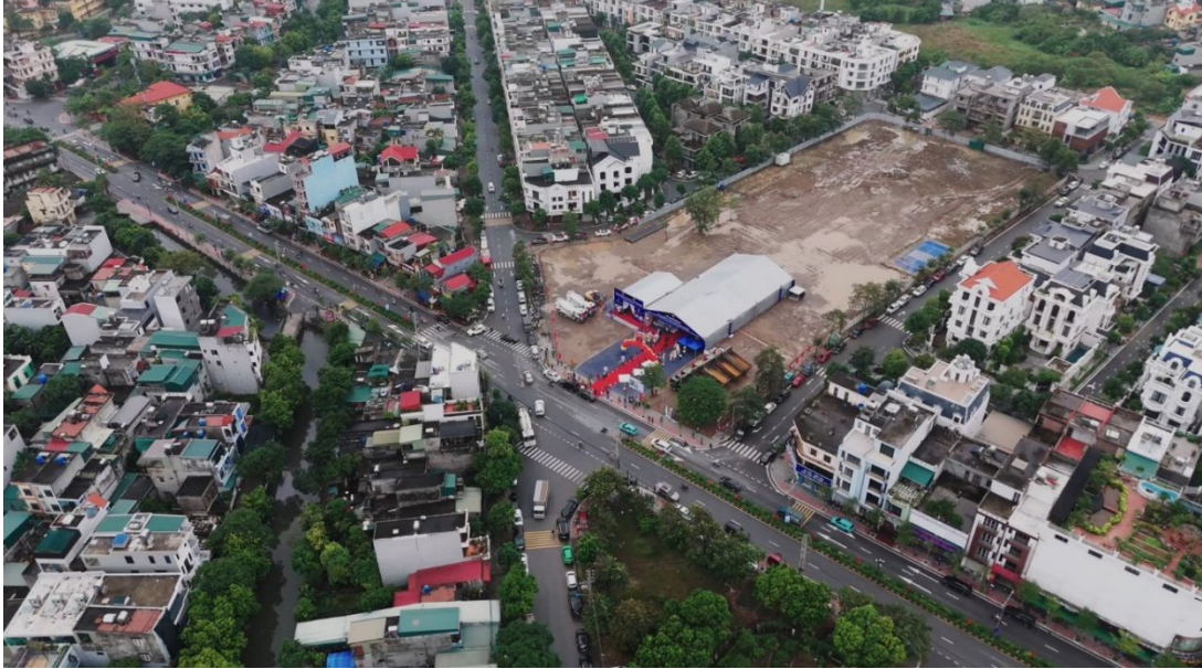
Hình 40: Lễ khởi công dự án NOXH Phú Xuân
